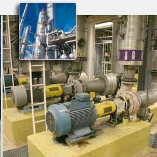
Easy-Laser® viene utilizzato per allineare pompe e motori per tutti i tipi di impianti, in una vasta gamma di settori. Per ridurre il consumo energetico e ottenere una vita utile ottimale, sono necessarie macchine perfettamente configurate e allineate.
